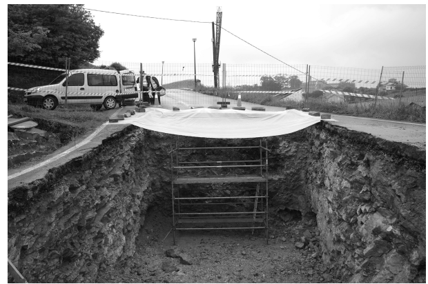
Figura 7: Corte sur (principal) del relleno sedimentario de la cavidad en el que se aprecia la colmatación del espacio cavernario cuyo techo rocoso habría sido eliminado durante la construcción de la calle de la Subida a la Cruz.
