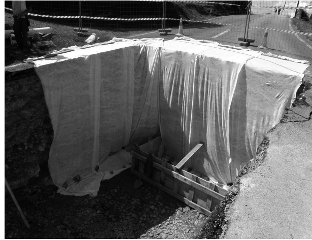
Figura 8: Trabajo de sellado de cortes arqueológicos, antes de procederse a la restauración de la hinca.
